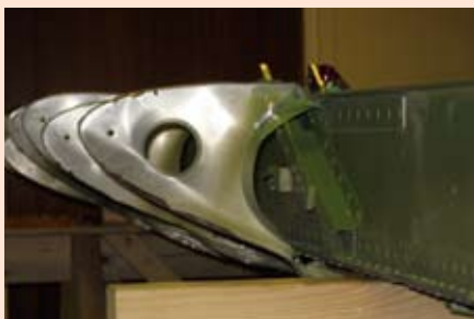
Demolerade och spruckna vingframkantspryglar!
