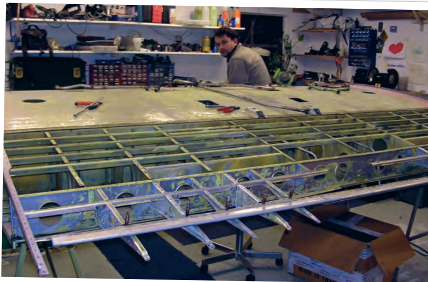
Skalplåten på översidan, några spant och stringers har bytts på mittvingen. Ett stort tack till Jonas Karlsson som har så små händer och kan hålla emot.
