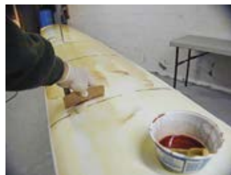
Avskrap av överflödig epox.
